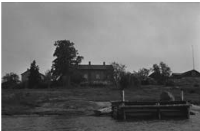
Skogsböle från sjösidan före ombyggnad. Bild: ÅABS
