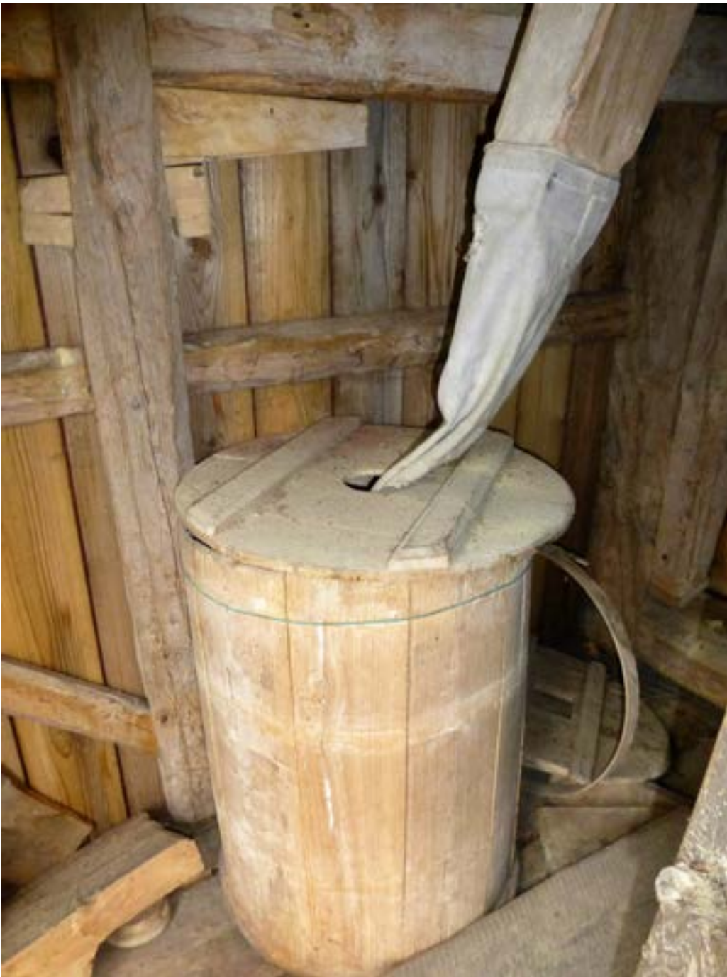
Valokuva 6: Puista jauhotorvea jatkettiin usein kankaalla. Taustaseinällä näkyvät yläkiven säätövivut. Kuva: Kirsti Horn, 2016.
