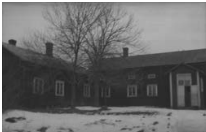
Grännas före ombyggnaden. Bild: ÅABS
