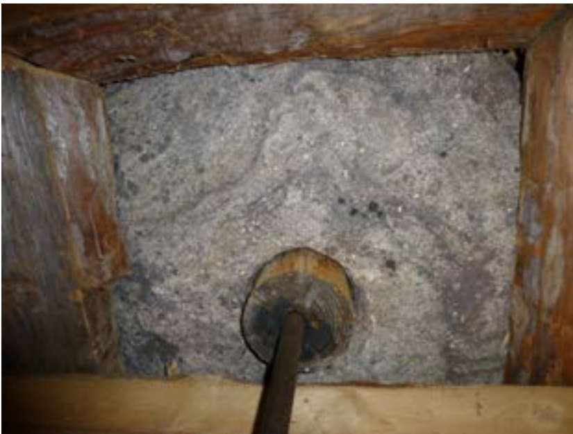
Valokuva 4: Alakiven pohja on jalkamyllyssä näkyvillä. Kuva: Kirsti Horn, 2016.
