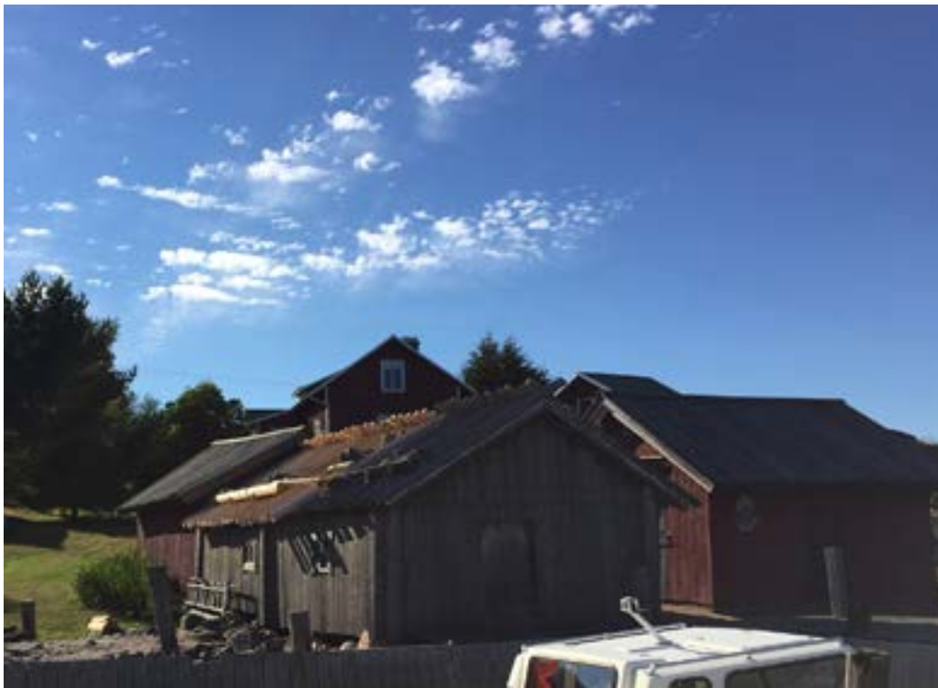
Reparation av vedtak i Berg- hamn, Nagu. Foto: Paula Saarento, 2018.
