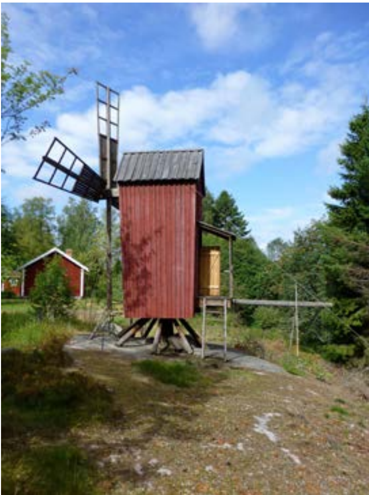
Valokuva 14: Korppoon museon myllyssä on avokuisti, lautakatto ja pelkät vinotuet napatukin tukena. Kuva: Kirsti Horn, 2016.
