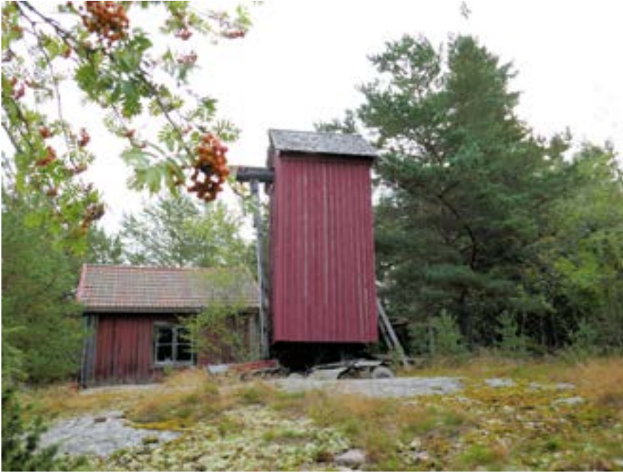
Valokuva 15: Vuonna 1736 rakennettu Jackoisin myllyvanhus Iniössä ei ulkoisesti poikkea myöhemmistä jalkamyllyistä. Mylly on yksityisomistuksessa. Kuva: Kirsti Horn, 2017.
