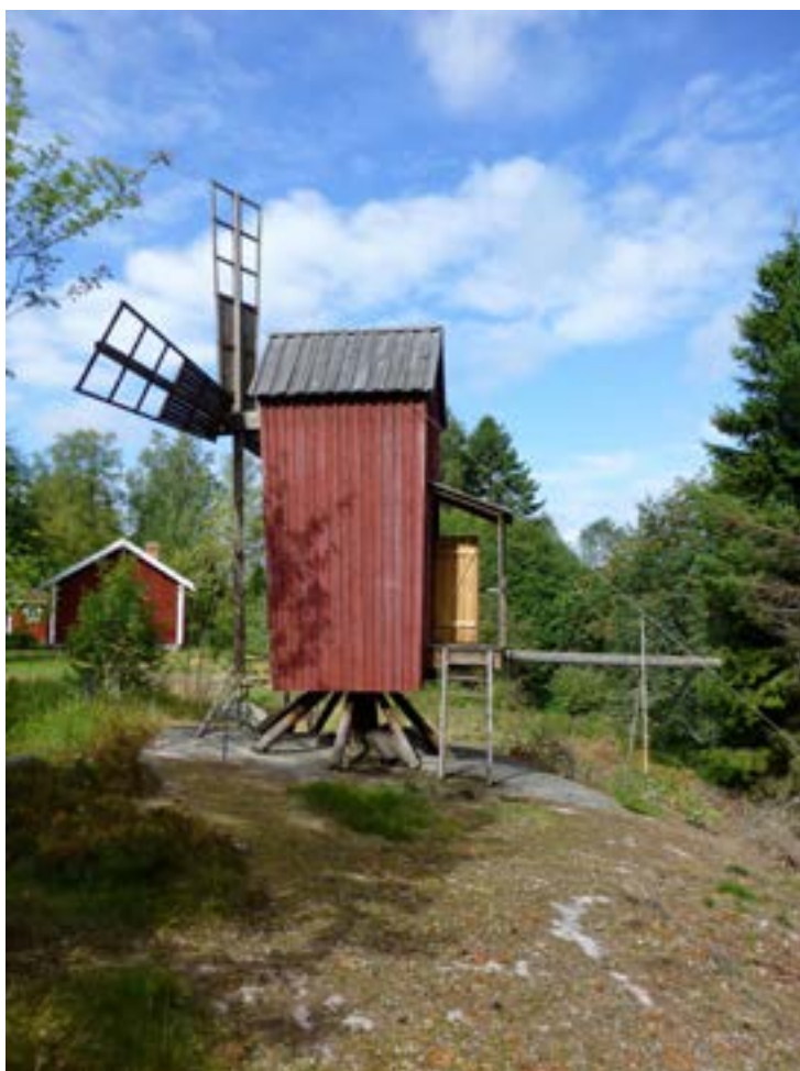
Foto 14: Korpo museums kvarn har en öppen kvist. Brädtak och bara strävor som stöder hjärtstocken. Foto: Kirsti Horn, 2016.
