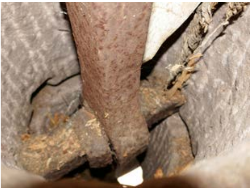
Valokuva 9: Tämä näkymä yläkiven silmästä on harvinaisen selvä, koska alakiven puutappi on pudonnut: siilirauta on lyhdynvarren kouran otteessa. Kuva: Kirsti Horn, 2017.
